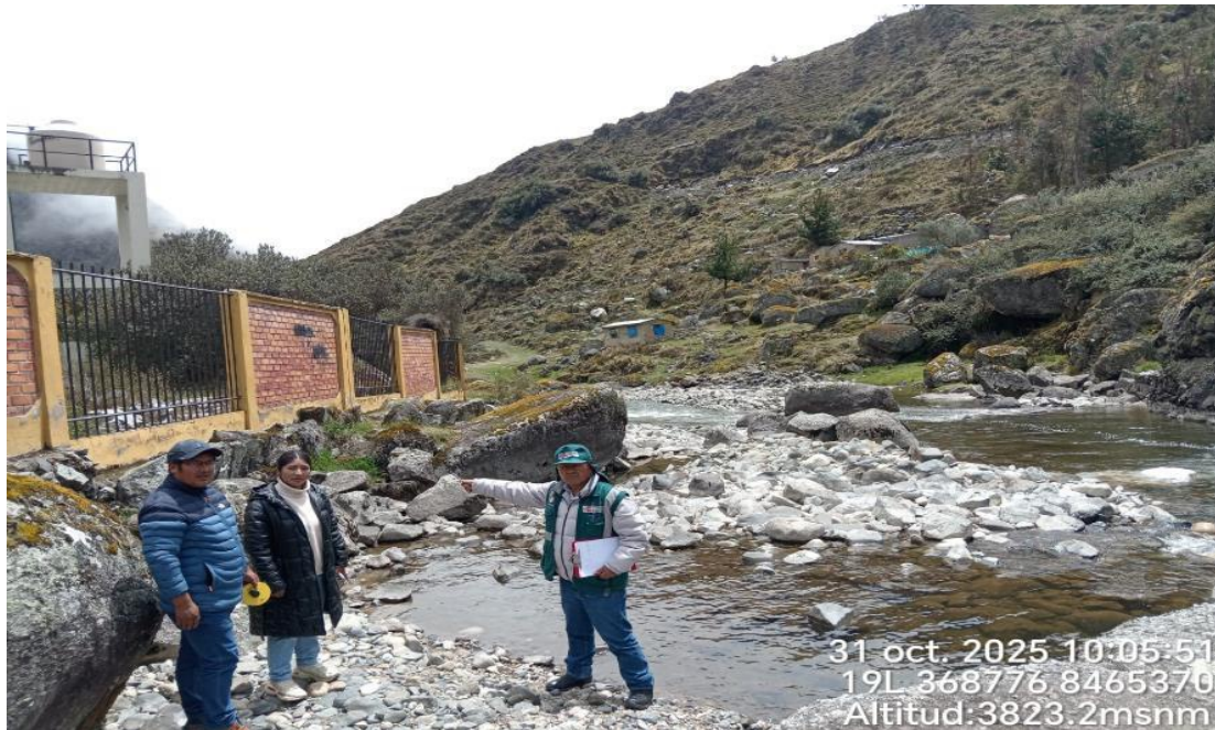
FOTO N° 01: SE MUESTRA LA MÁRGEN DEL RIO TAMBILLO QUE CAUSA SOCAVAMIENTO EN LA MÁRGEN IZQUIERDA, AFECTANDO VIVIENDAS.
