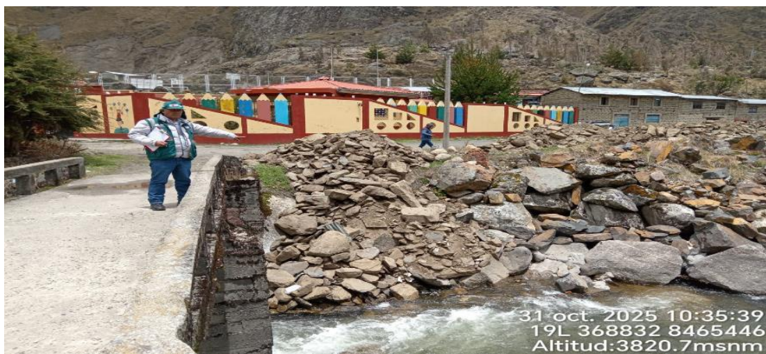
FOTO N° 02: SE MUESTRA LA MÁRGEN DEL RIO TAMBILLO QUE CAUSA SOCAVAMIENTO EN LA MÁRGEN IZQUIERDA, AFECTANDO VIVIENDAS.
